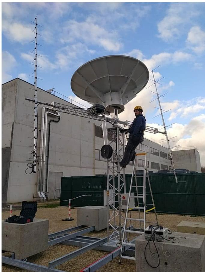
*Intégration d'une antenne bande S et essais de communication avec le satellite UVSQ-SAT NG.*
