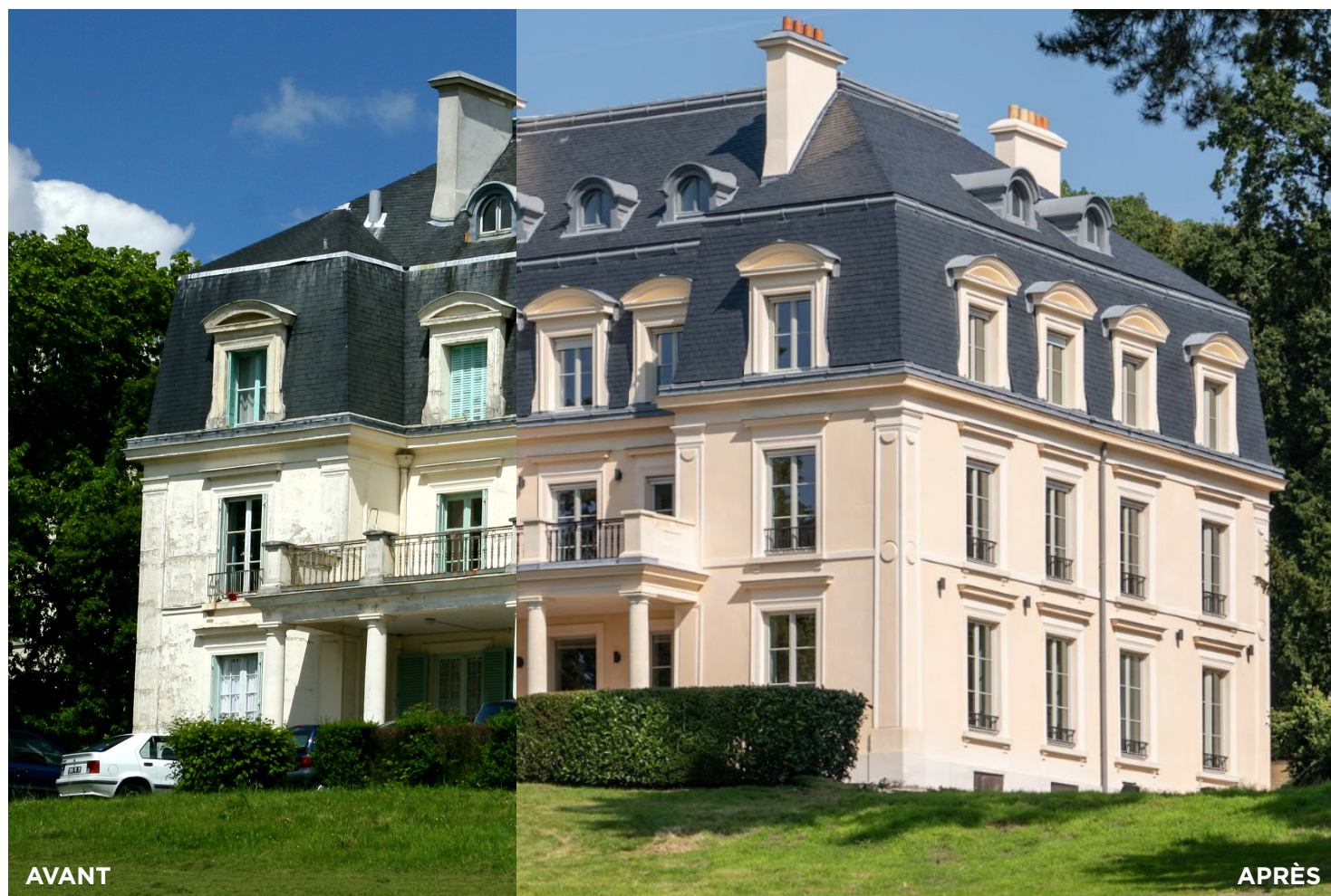
Rénovation du Pavillon Panhard - Campus de Versailles
