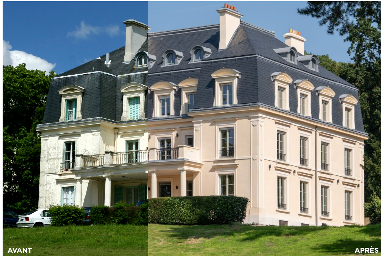
Rénovation du Pavillon Panhard - Campus de Versailles
