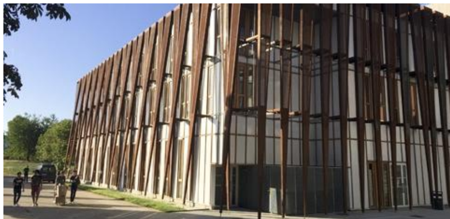
Maison de l'étudiant Marta Pan-Campus de Guyancourt
