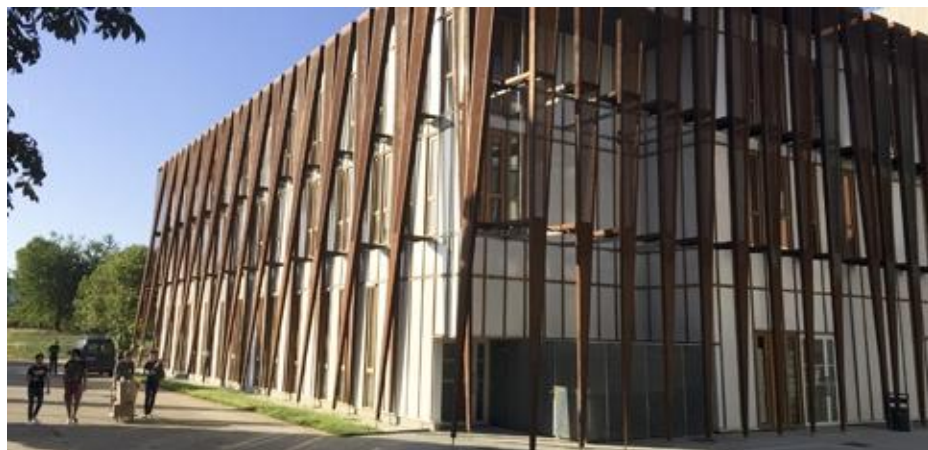
Maison de l'étudiant Marta Pan-Campus de Guyancourt
